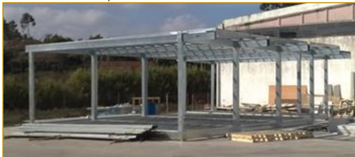
Figura 3: Estrutura de três módulos sendo realizada na parte externa da fábrica
