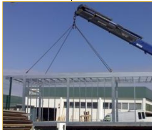
Figura 4: Estrutura de um módulo sendo transportada
