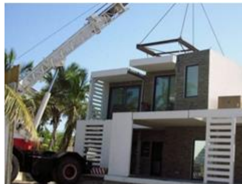
Figura 6: Módulo sendo instalado
